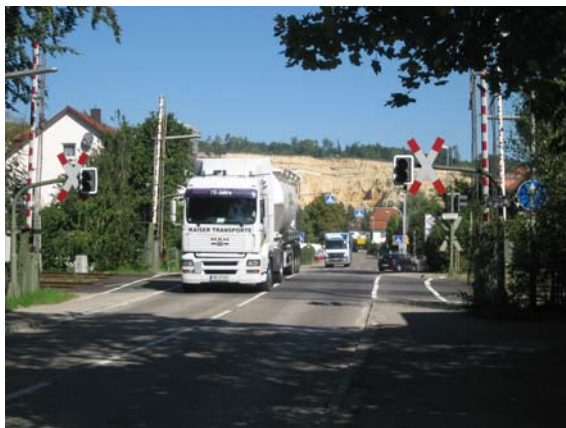
Abbildung 6: Bahnübergang Ulmer Straße (B28)
